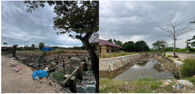
Saluran Air di sekitar Gedung Rumah Produksi Pangan
